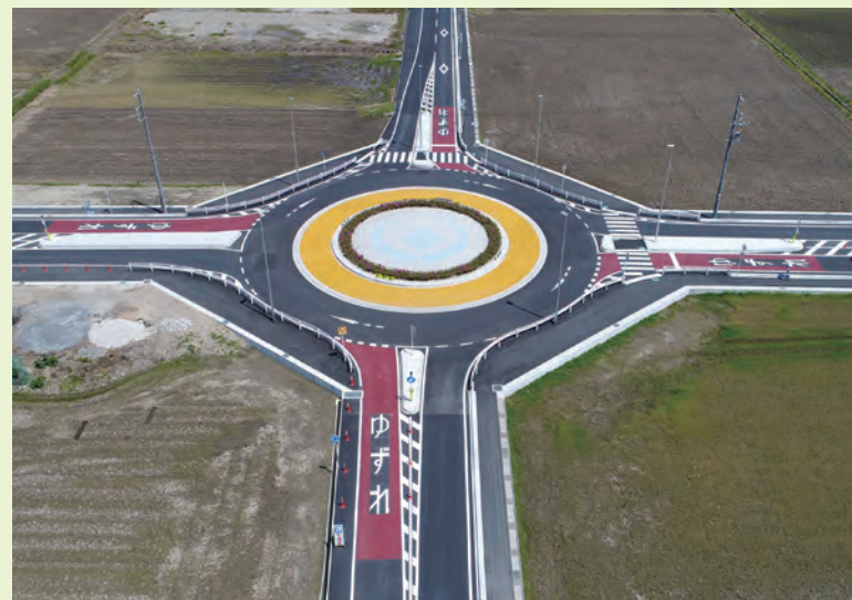
安インター東交差点(岐阜県安八郡安八町)
